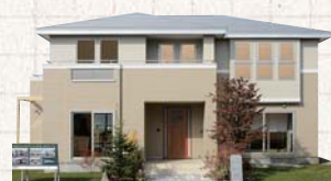
日本ハウスHD エコボックス ☎0138/47/9001 木造軸組住宅
