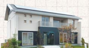
日本ハウスHD 時の鐘III ☎0138/46/5451 木造軸組住宅
