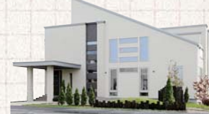
東商建設 ☎0138/46/4645 木造軸組住宅
