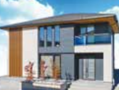
日本ハウスHD Tel.0138-76-3255 木造軸組工法
