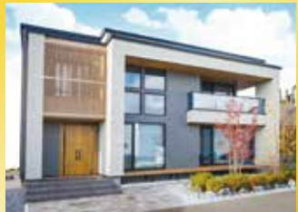
日本ハウスHD Tel.0138-76-6832 木造軸組工法
