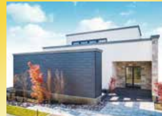
土屋ホーム Tel.0138-83-7715 木造軸組工法
