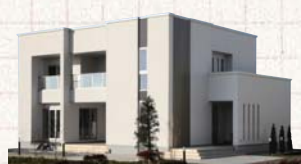
株式会社 タマホーム ☎0138/46/0638 木造軸組住宅
