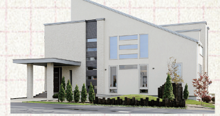
東商建設 ☎0138/46/4645 木造軸組住宅
