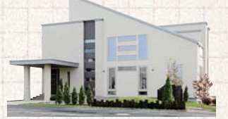
東商建設 ☎0138/46/4645 木造軸組住宅
