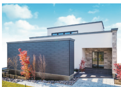
土屋ホーム Tel.0138-83-7715 木造軸組工法
