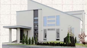
東商建設 ☎0138/46/4645 木造軸組住宅
