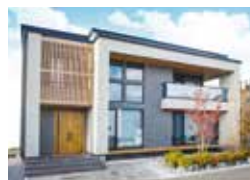
日本ハウスHD Tel.0138-76-6832 木造軸組工法
