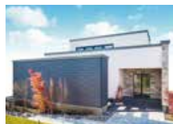
土屋ホーム Tel.0138-83-7715 木造軸組工法
