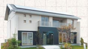
日本ハウスHD 時の館III ☎0138/46/5451 木造軸組住宅
