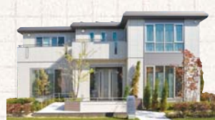
北海道セキスイハイム ☎0138/47/8163 鉄骨ユニット住宅
