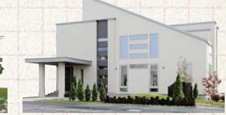
東商建設 ☎0138/46/4645 木造軸組住宅
